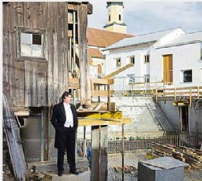
Kulturbaustelle mitten in Blaubach: Thomas E. Bauer auf dem Gelände seines 1,6-Millionen-Euro-Projekts. FOTO: FKM
